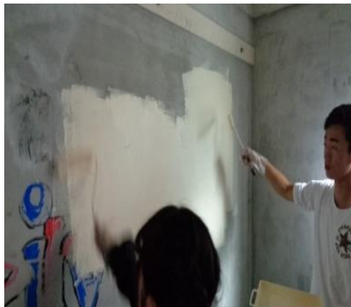
部室内塗装（落書き部分の塗装）
