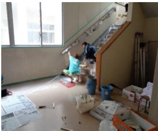
廊下壁塗装（汚れた部分の塗装）
